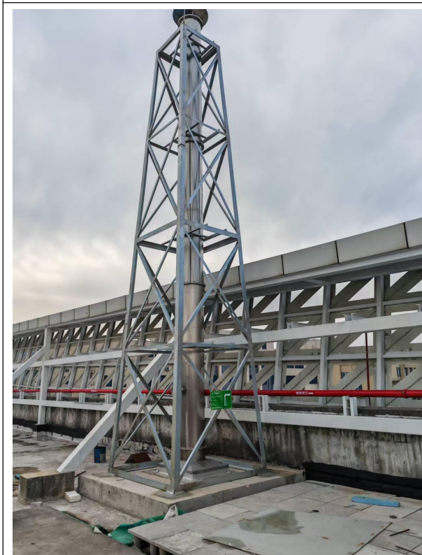
车间粉尘废气排放口及废气排放口标志牌JW-FQ-1147-2
