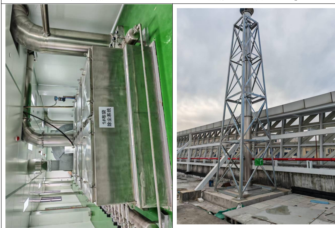
喷雾干燥粉尘废气处理设施一套（布袋除尘器及排气筒 JW-FQ-1147-2）
