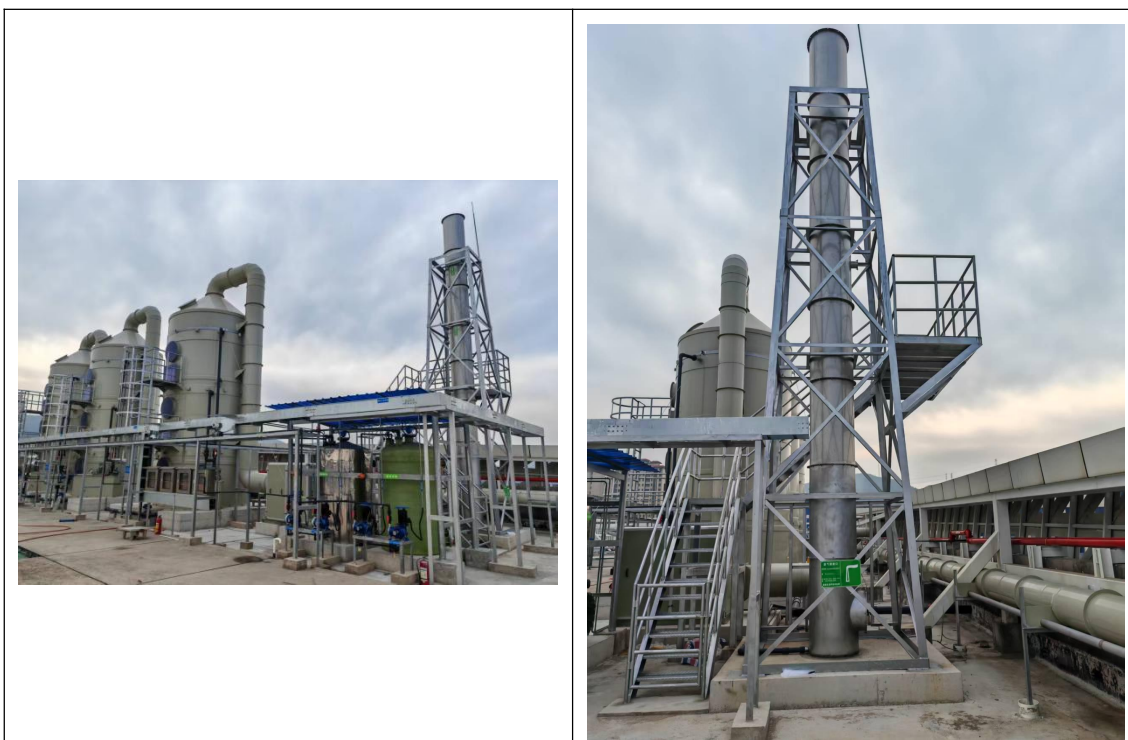
工艺+污水处理臭气等废气处理设施一套（三级喷淋及排气筒 JW-FQ-1147-1）
