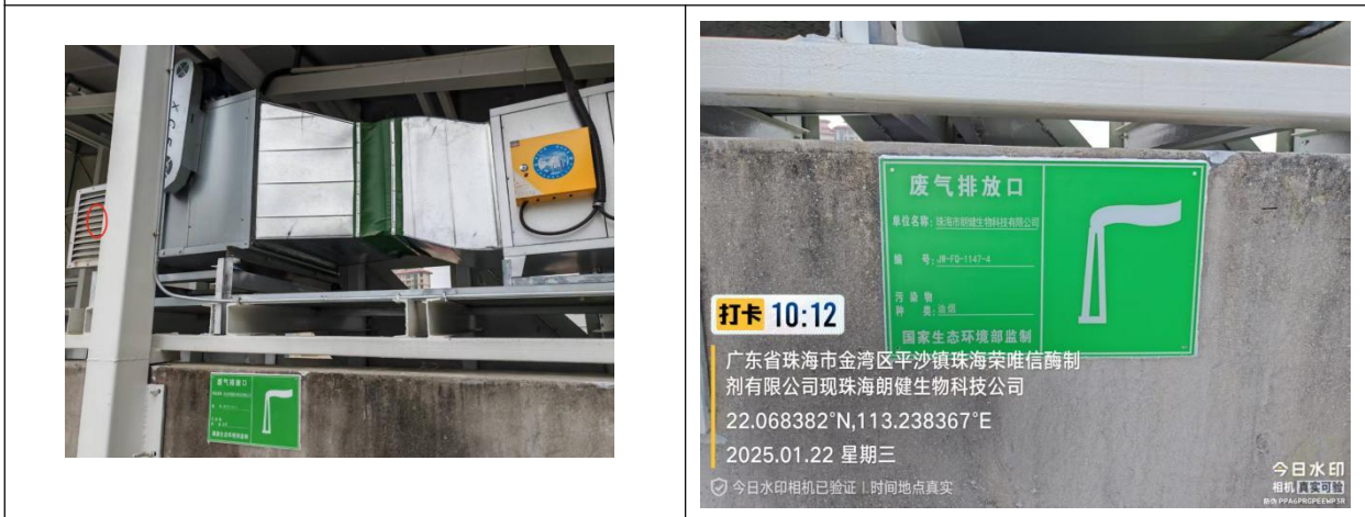
食堂油烟废气处理设施和及废气排放口标志牌JW-FQ-1147-4
